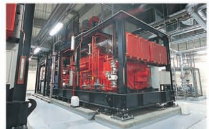
Reducción de las emisiones de CO 2 con un sistema de cogeneración altamente eficiente
