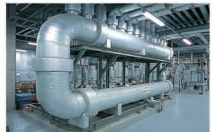
Este sistema de intercambio de calor enfría nuestro equipo de moldeo por inyección con calor de un generador eléctrico.
